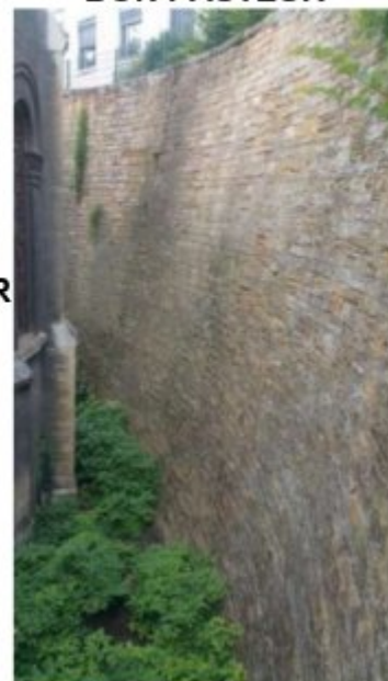
MUR SOUTAINEMENT BON PASTEUR
